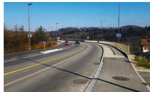
Die Pérolles-Brücke im Pandemie-Ausnahmestand – eine potenziell lehrreiche Erfahrung.
